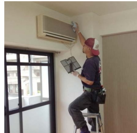
エアコン清掃中
